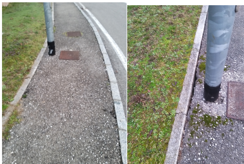
Attuale posizione pali illuminazione e zone con lieve assestamento della zona in prossimità del palo
