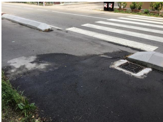
Via Corticella – cordonata in cls di protezione del percorso pedonale
