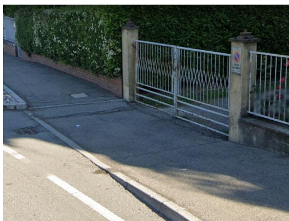
Via Lirone – passo carraio con piazzola centrale a raso e rampe con pendenza adeguata (massimo 5%)
