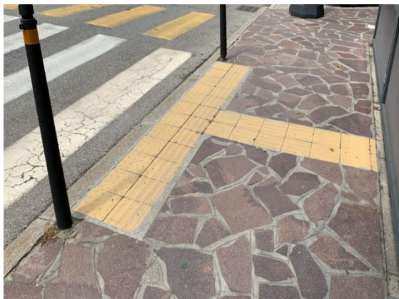
Via Lame – segnaletica tattile di orientamento posta in maniera adeguata
