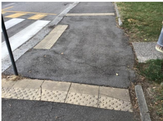
Via Lirone – segnaletica tattile di orientamento posta in maniera scorretta
