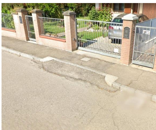
Via Berlinguer – passo carraio con rampa in corrispondenza della cordonata e percorso avente larghezza minima di 90 cm
