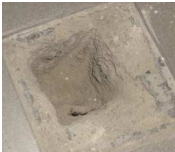
SONDAGGIO 5: solaio di calpestio piano secondo in travetti di cls e polistirolo.
