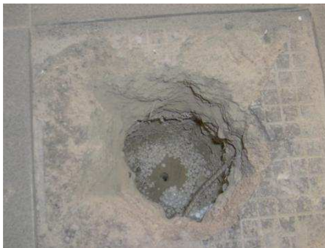
SONDAGGIO 2: solaio di calpestio piano terra in travetti di cls e polistirolo.
