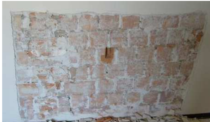
SONDAGGIO 4: muratura in mattoni semipieni.
