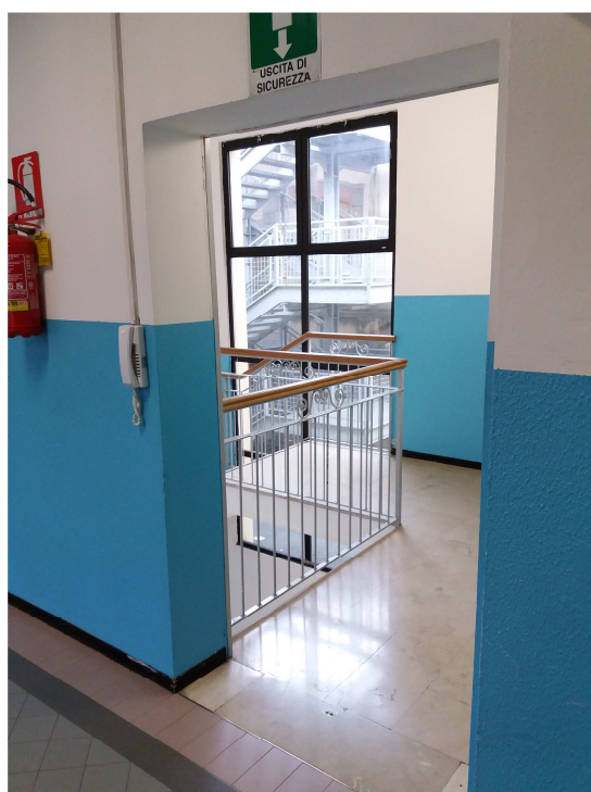
Foto 45 con indicato il pianerottolo e l'apertura oggetto di intervento a seguito della creazione del nuovo giunto e della muratura armata
