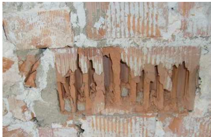
SONDAGGIO 5: solaio di calpestio piano secondo in travetti di cls e polistirolo.
