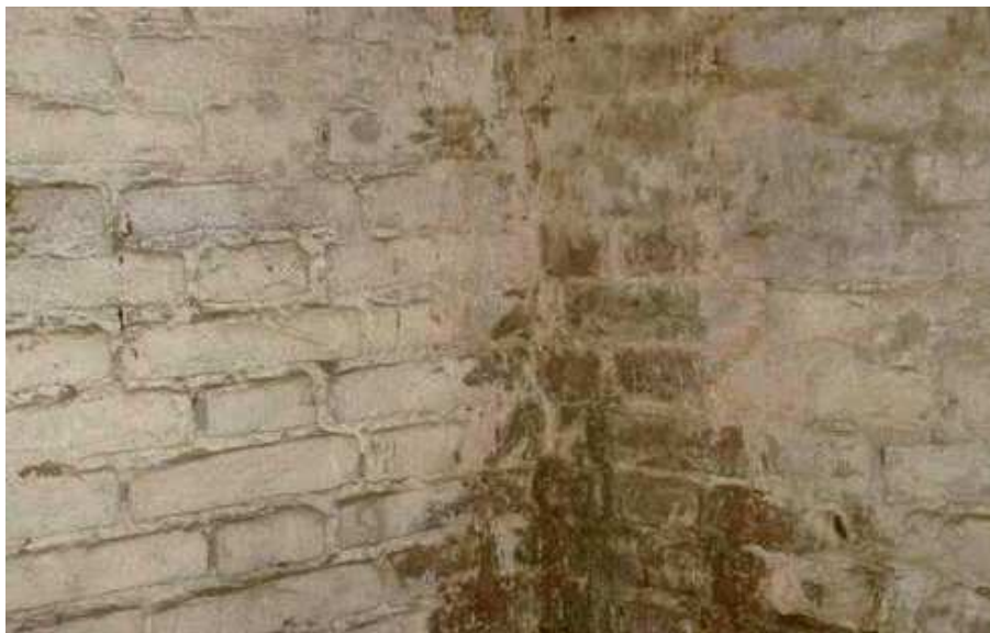
SONDAGGIO 1: muratura in mattoni pieni.
