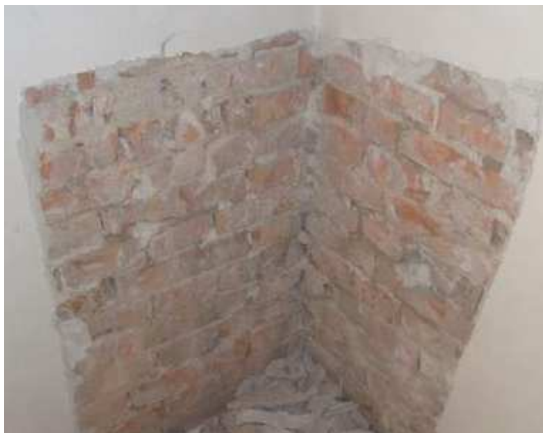
SONDAGGIO 6: muratura in mattoni pieni.
